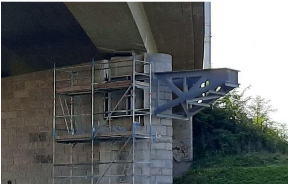
Abbildung 4: Stahlkonsole an einer Pfeilerscheibe
